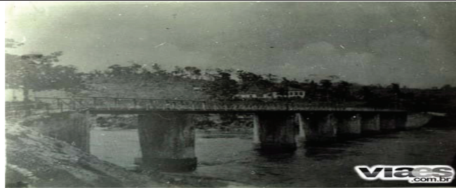
Foto 2 – Ponte Municipal Fonte: www.viaes.gov.br
