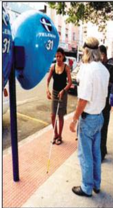
Faixa tátil orienta o deficiente visual
