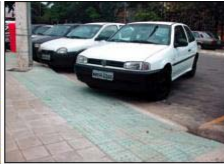
Rampas construídas corretamente
