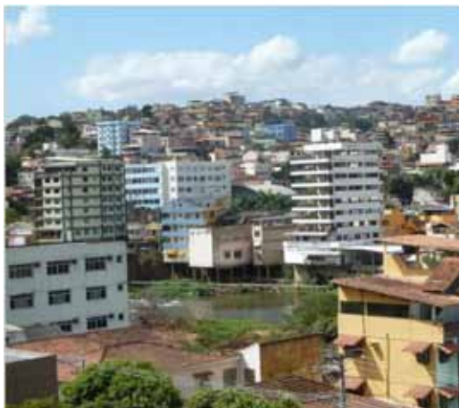
Trecho 6 - Margem esquerda ao fundo (2016).
