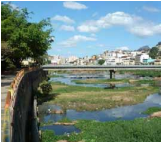
Trechos 7 e 8 - Ponte ao fundo (2015).
