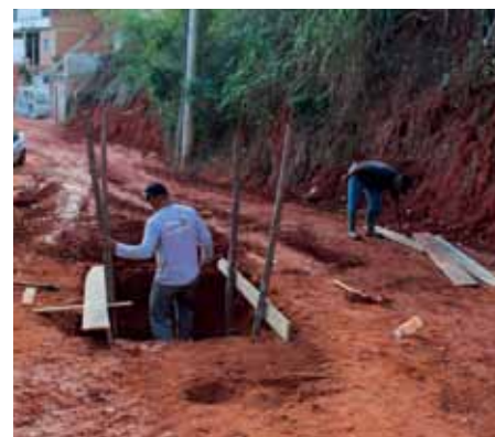
Muro de contenção está sendo construído na rua Wilson Duarte
