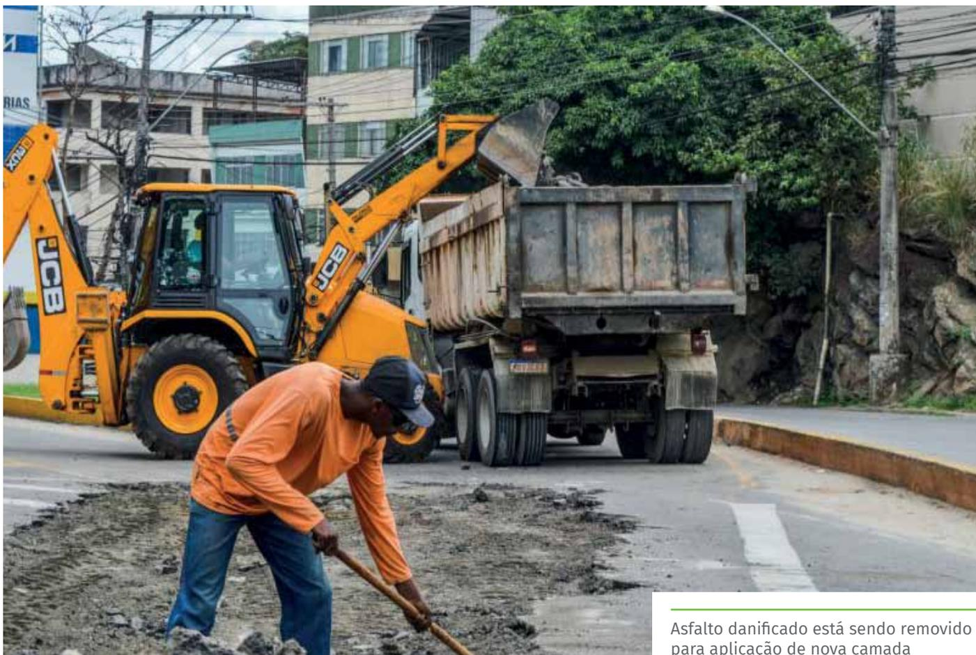
Asfalto danificado está sendo removido para aplicação de nova camada
