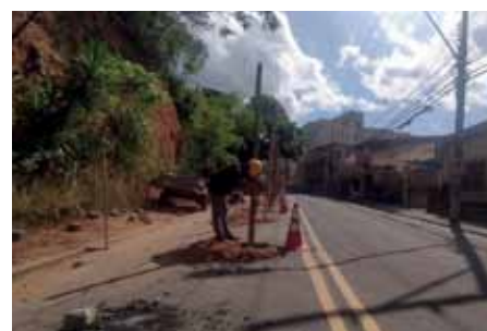
Intervenções contemplam trecho de 200 metros entre padaria e ponto de ônibus
