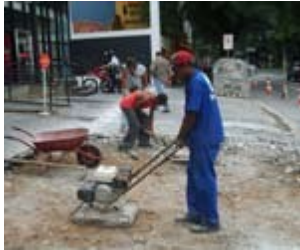
Nivelamento e compactação do subleito (terreno)
