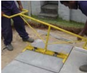
Colocação das peças de concreto com saca-placas
