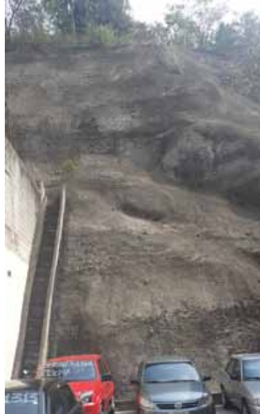
Figura 26 – Adequação de canais para retardamento do escoamento por degraus, Bairro Parque Laranjeiras
