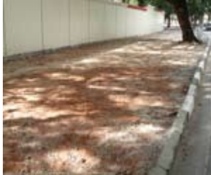
Nivelamento e compactação do subleito (terreno)
