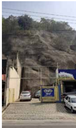
Figura 22 – Revestimento de talude, Bairro Parque Laranjeiras
