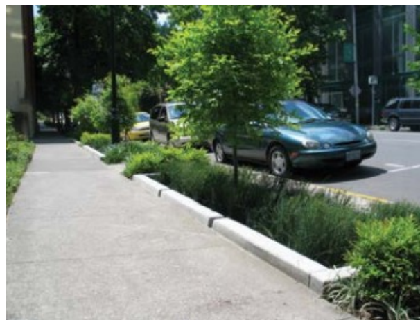
Figura 6 – Jardim de Chuva na Calçada – Projeto Implantado
