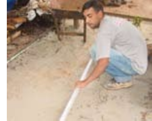
Espalhamento e nivelamento (sarrafeamento) da areia de assentamento (pó de brita)
