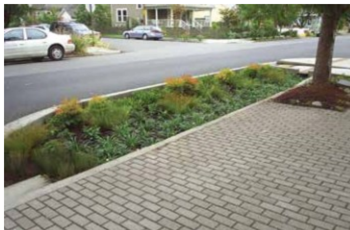
Figura 8 – Jardim de Chuva na Via – Projeto Implantado
