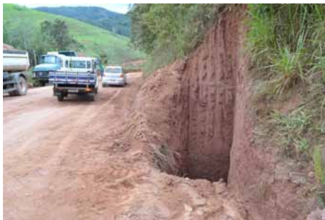
Figura 24 – Caixa seca em estrada rural
