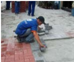
Colocação das peças de concreto, alinhamento, cortes e ajustes
