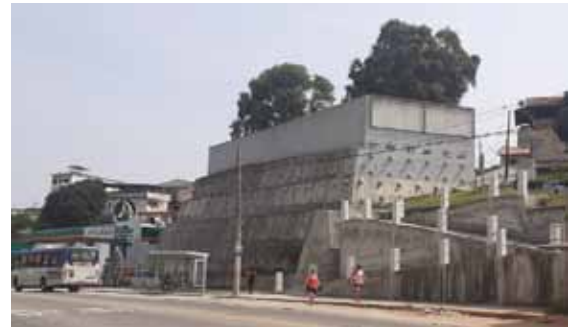
Figura 21 – Muro de arrimo, Bairro Caiçara
