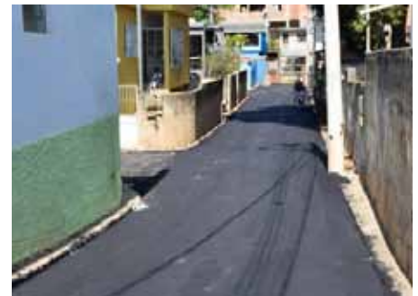
A rua Mem de Sá, no Baiminas, foi asfaltada na semana passada
