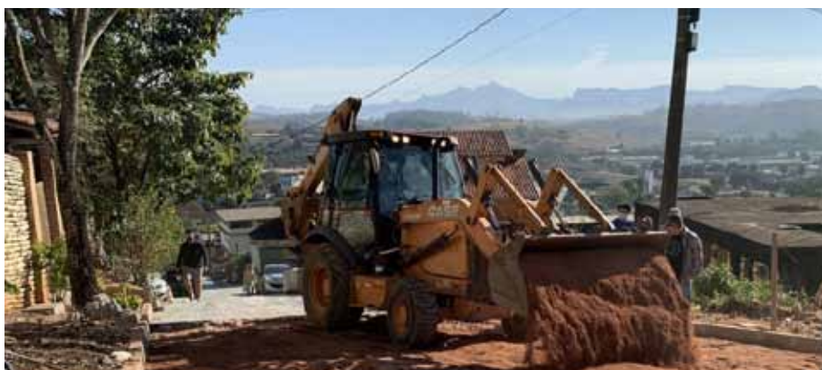
A previsão é que as obras sejam concluídas em dezembro deste ano
