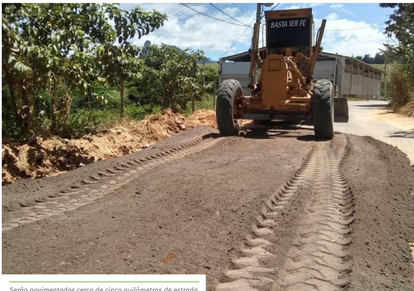
Serão pavimentados cerca de cinco quilômetros de estrada
