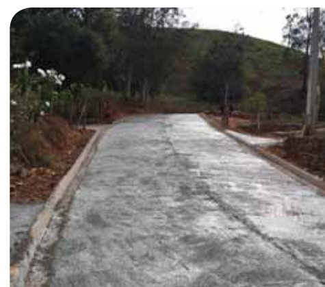
Em Santa Fé, rua sem calçamento ganhou pavimentação com concreto
