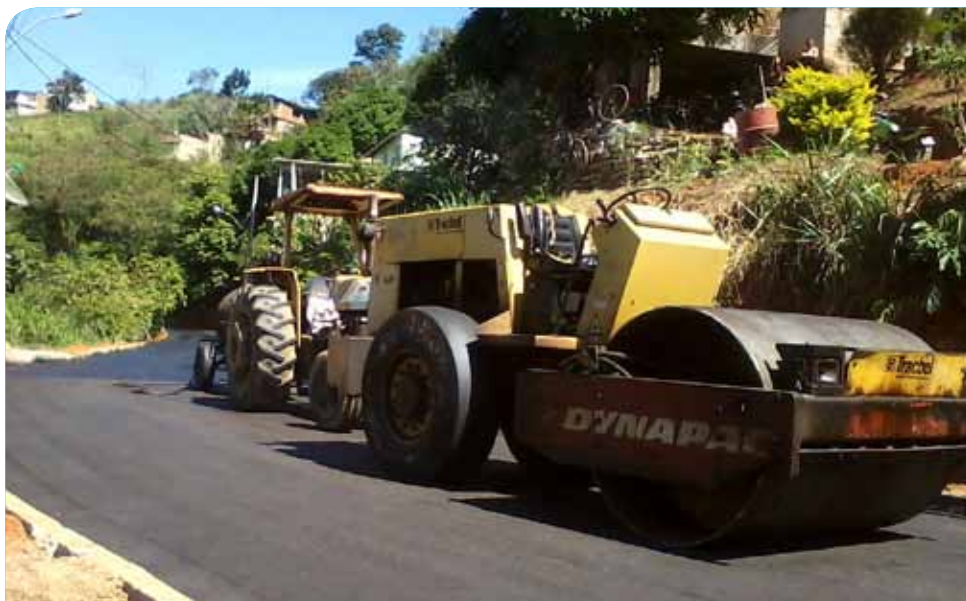
Serão executados serviços de drenagem, pavimentação (foto) e construção de muros de contenção e escadarias
