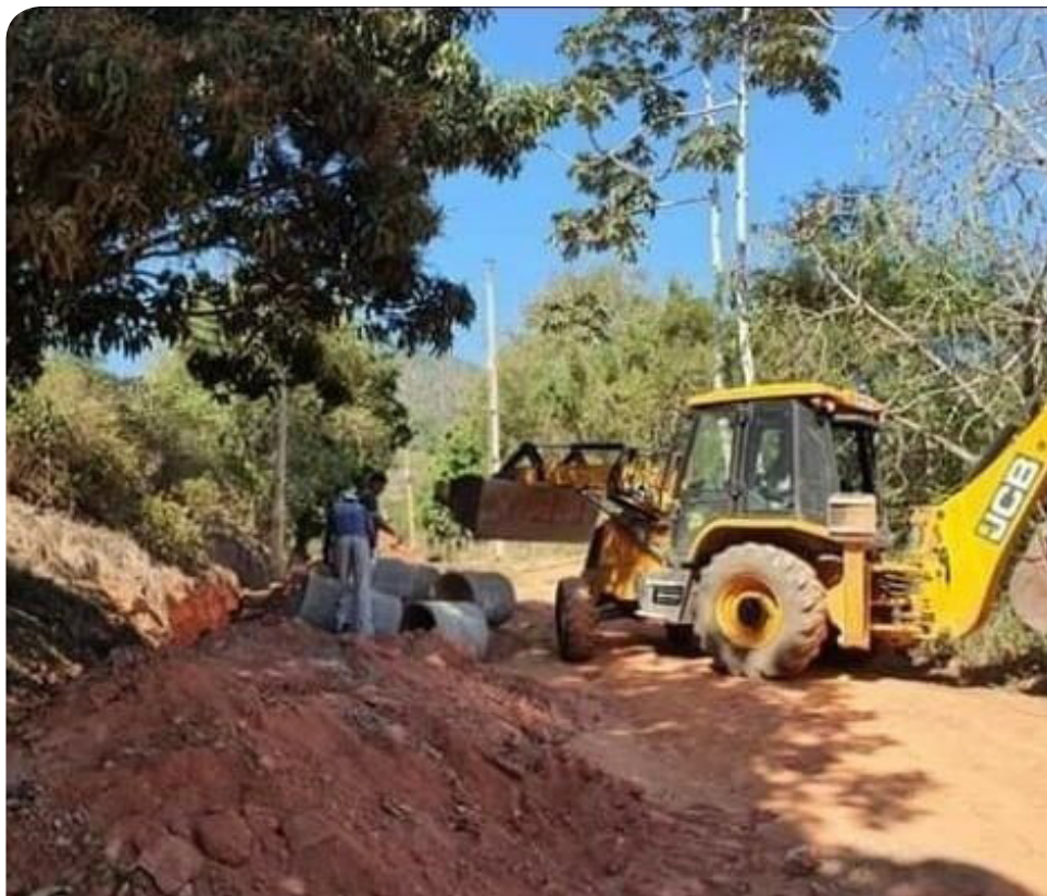
Ação vai melhorar escoamento da água em trecho da Rodovia Cachoeiro - Muqui
