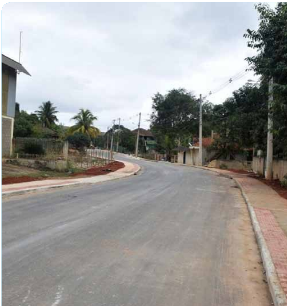
A rua Roque Paschoal, que está entre as contempladas, recebeu drenagem, pavimentação e passeio público
