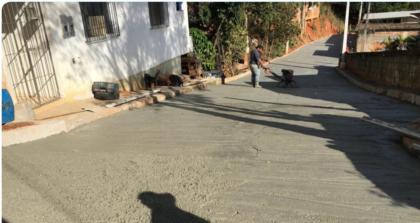
A via, antes, era toda de chão batido
