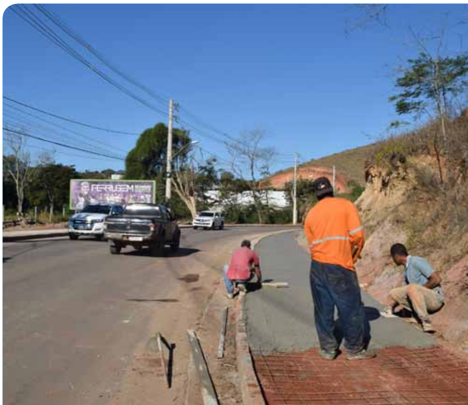
Calçada cidadã começou a ser feita na semana passada
