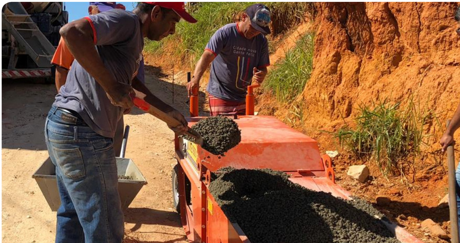
A extrusora de meio-fio começou a ser operada na semana passada
