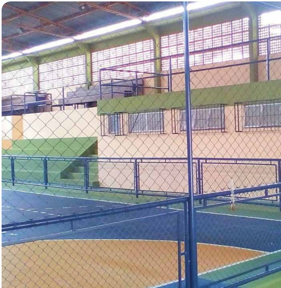
Intervenções incluem reparos no piso, nos banheiros e na calçada do entorno
