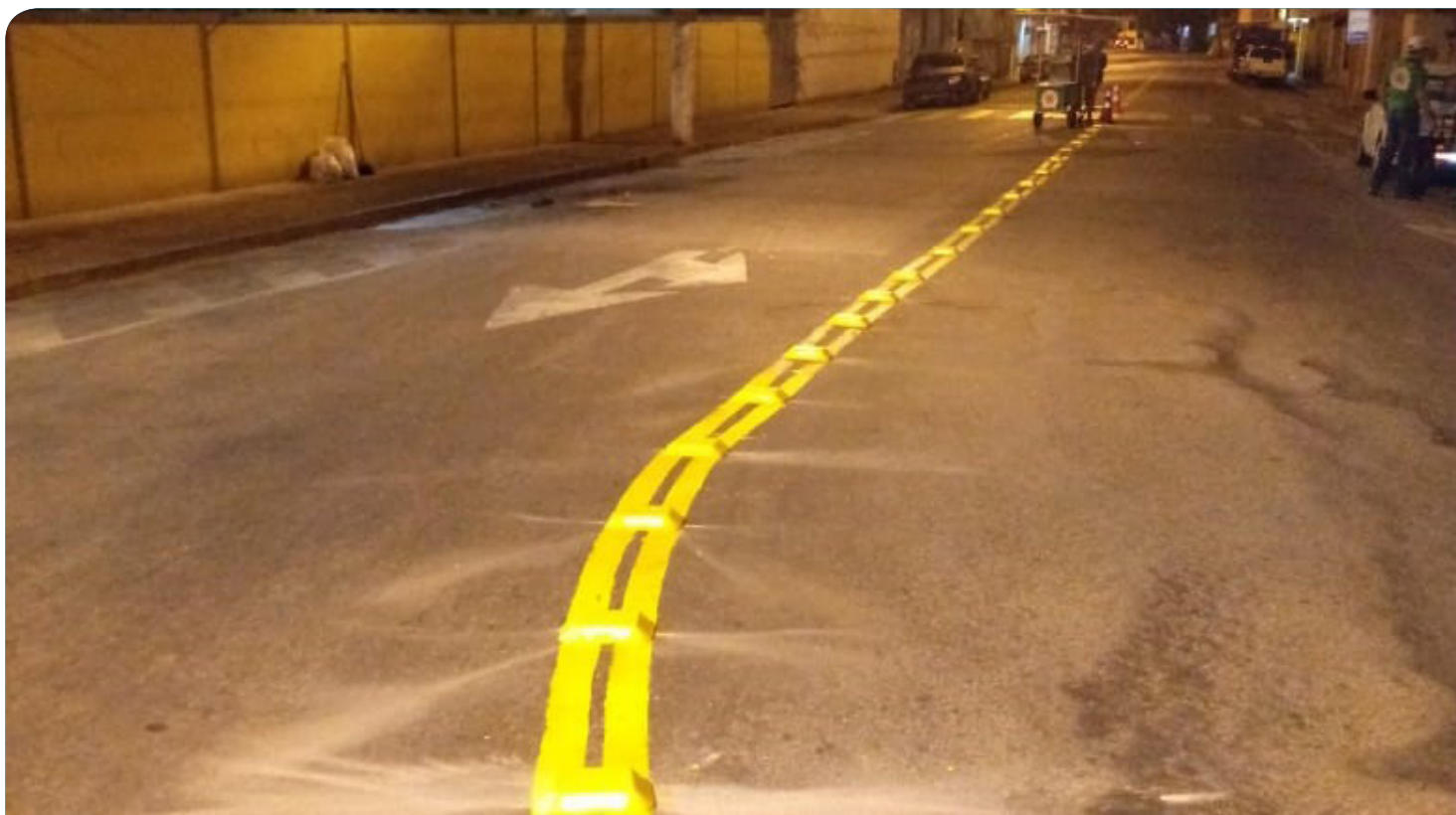
Uma delas é a avenida Nossa Senhora da Consolação, que recebeu tachões refletivos
