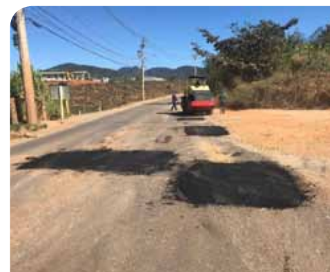
A Secretaria de Obras já iniciou uma operação para reparo na pavimentação no acesso à localidade
