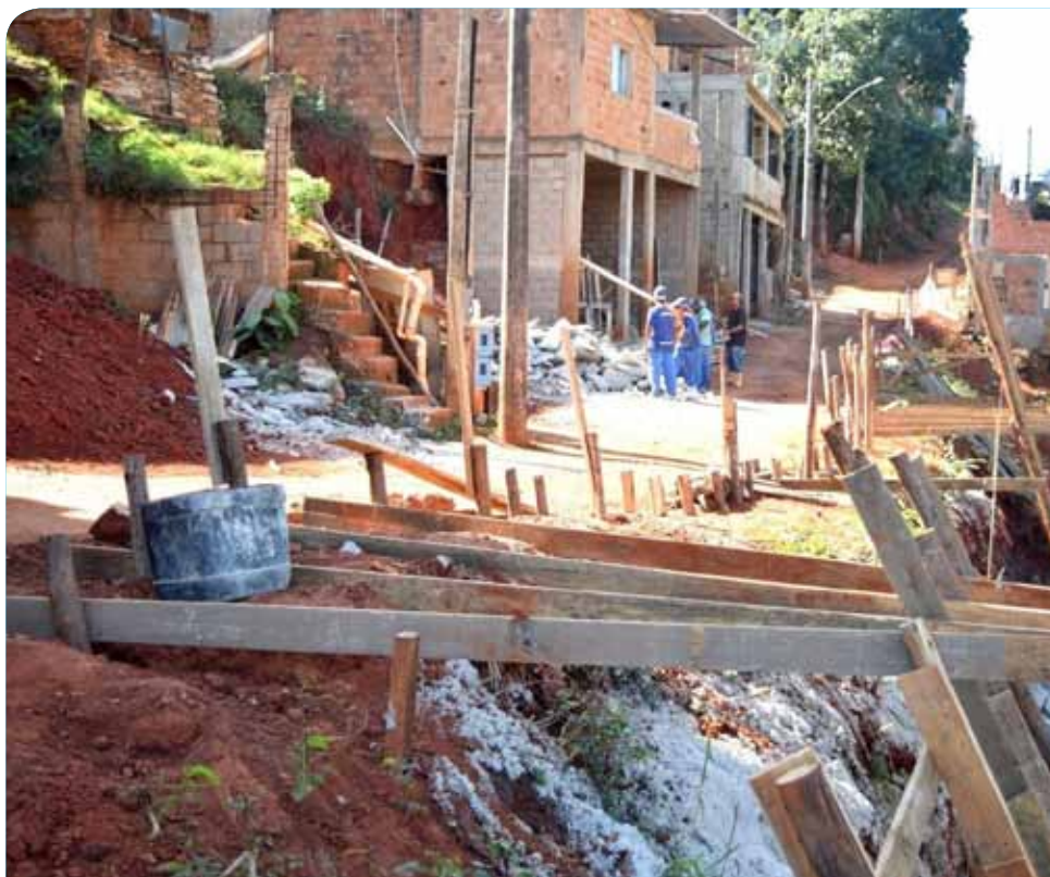
O prazo de conclusão é de 360 dias, aproximadamente
