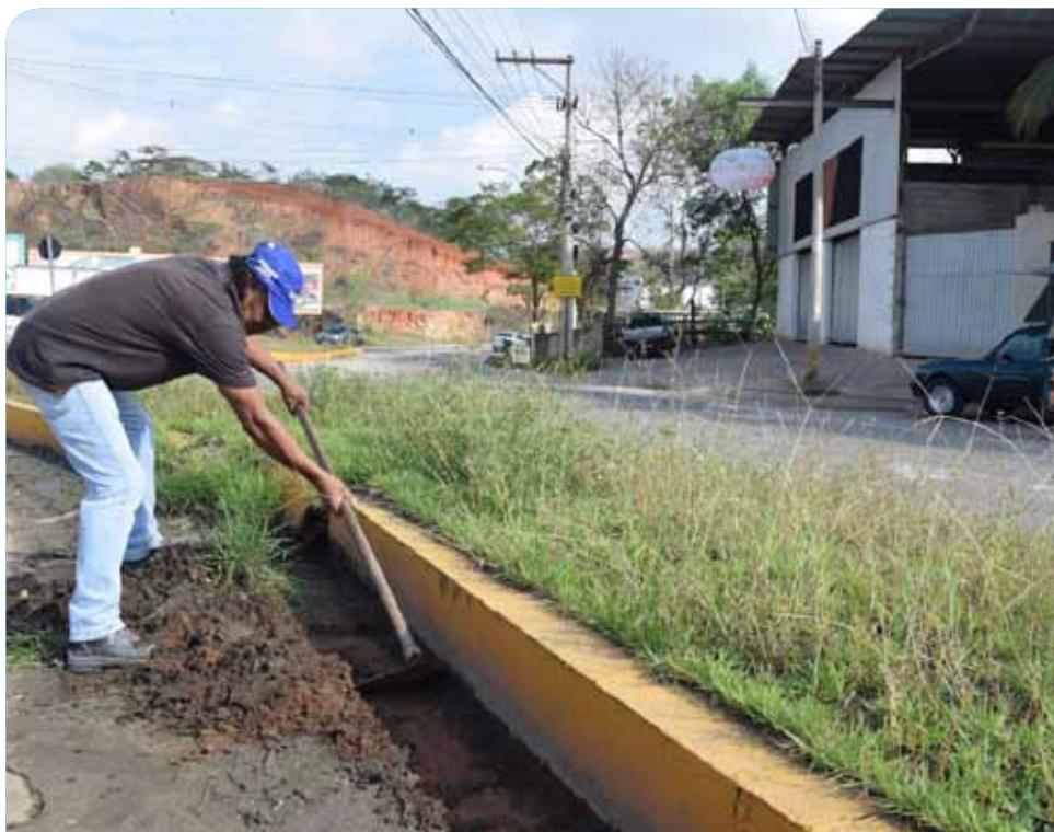
O prazo para a conclusão dos trabalhos é de 15 dias, aproximadamente
