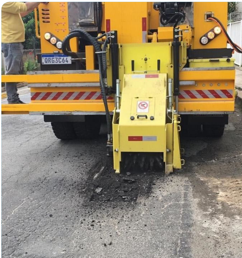
Caminhão adquirido pela prefeitura conta com acessórios para realização do trabalho
