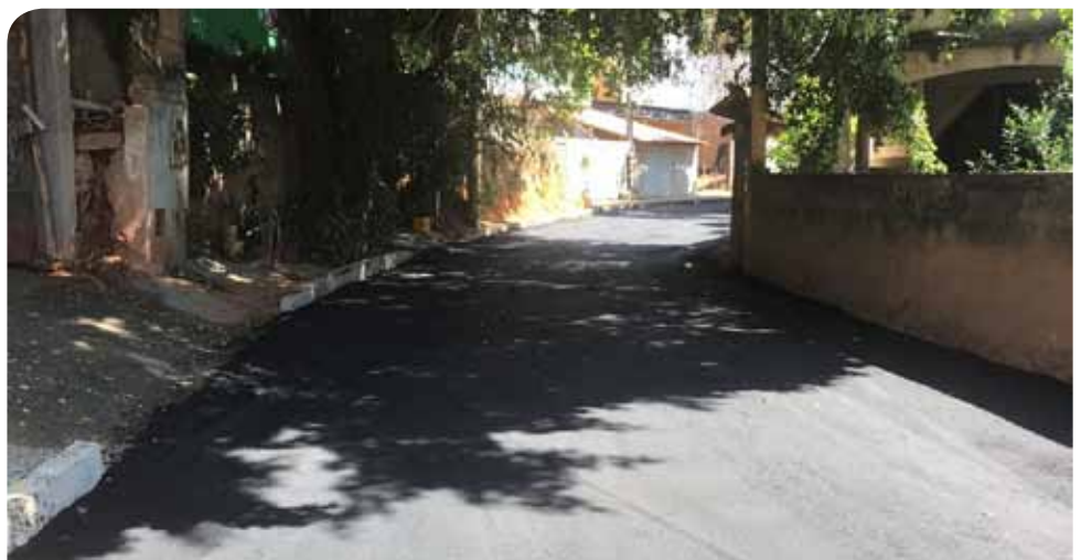
O asfaltamento é um complemento das melhorias realizadas na rua Antonieta Contarini
