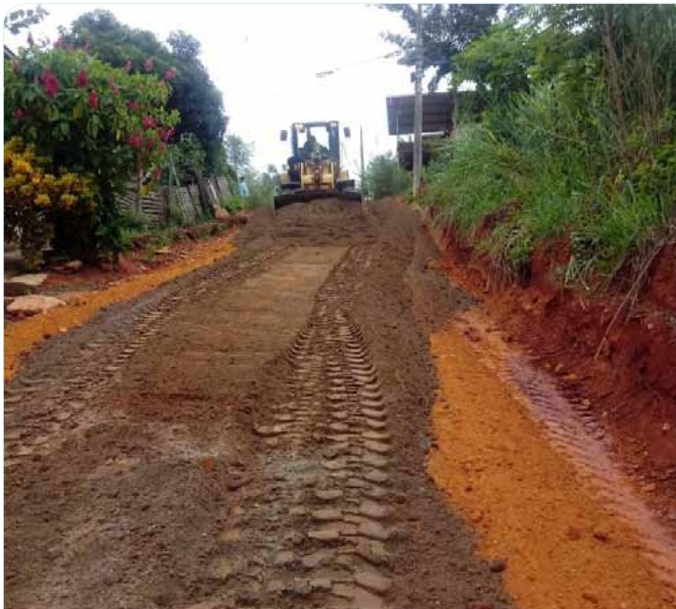
Em outras três vias do bairro, estão em fase final obras de pavimentação em paralelepípedo
