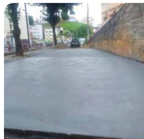
O espaço já conta com novo piso de concreto na área externa
