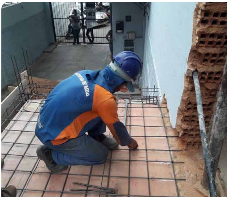
Construção de rampas e escadas de acesso está entre as intervenções
