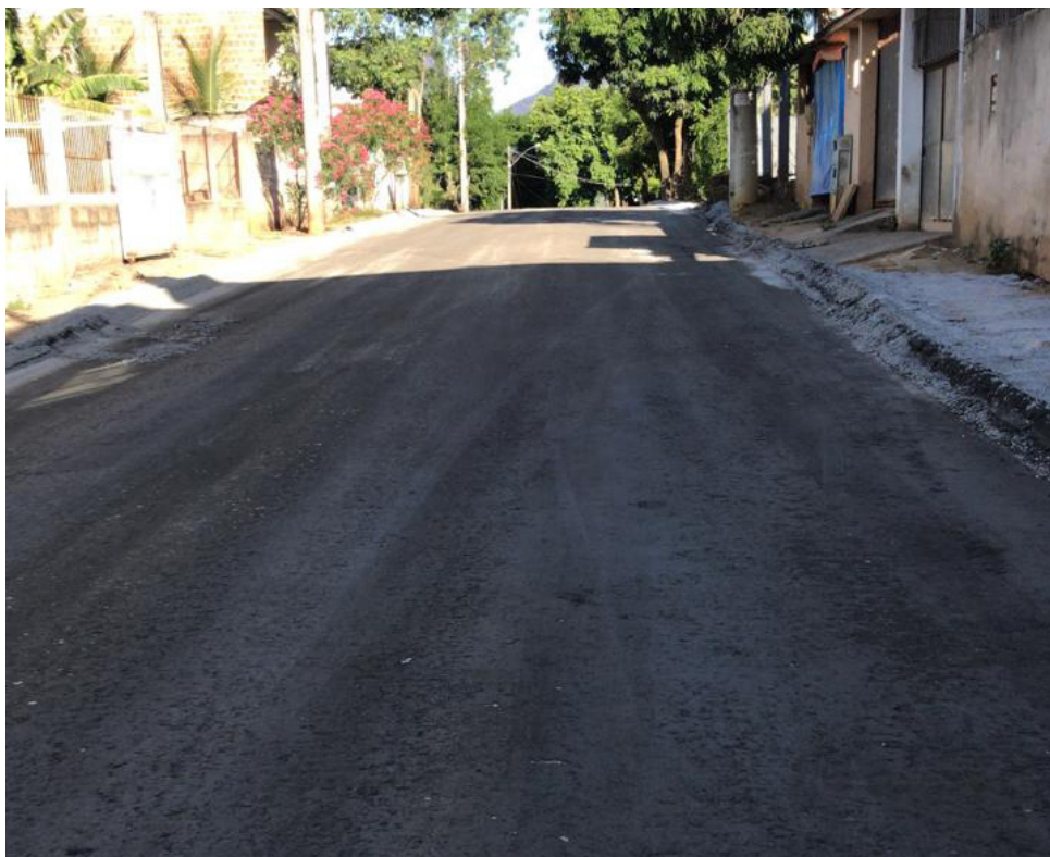
Material usado é o Revsol, resultante da fabricação de aço
