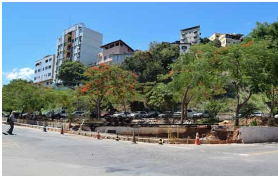
A fase atual dos serviços é de construção do novo passeio
