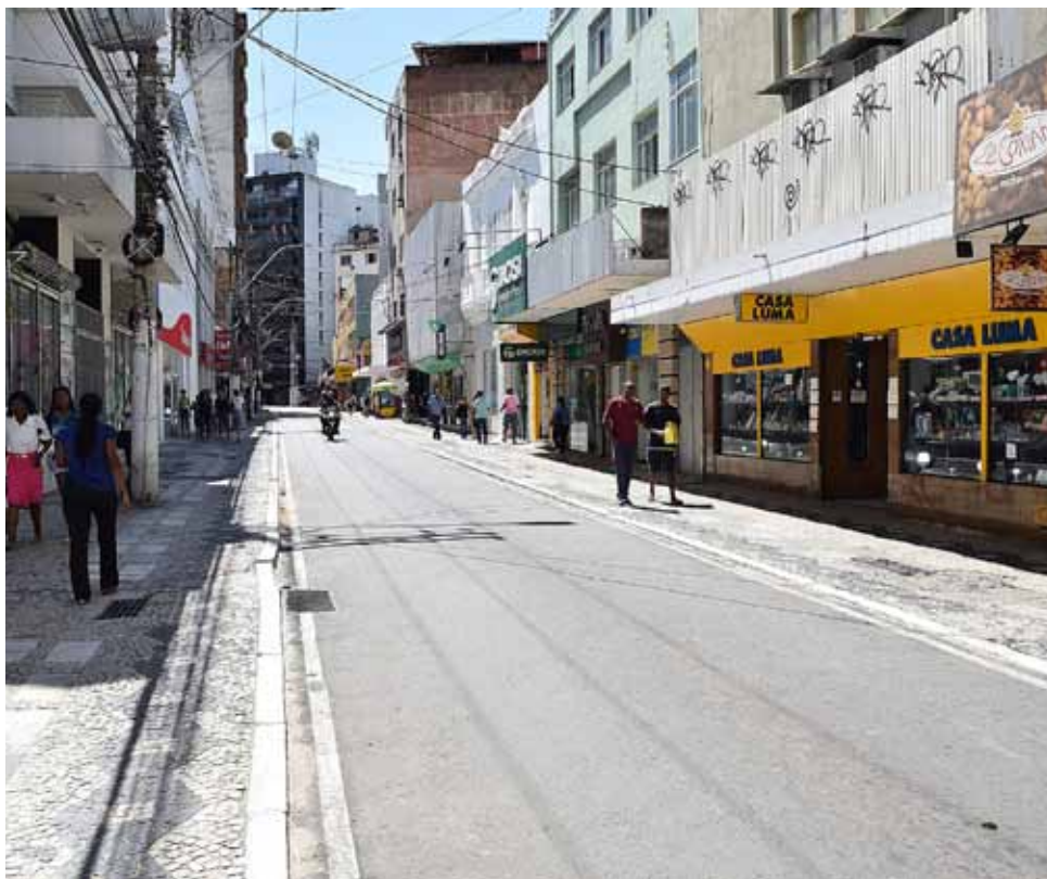
Primeira etapa do projeto elaborado pela prefeitura é a substituição do pavimento da via
