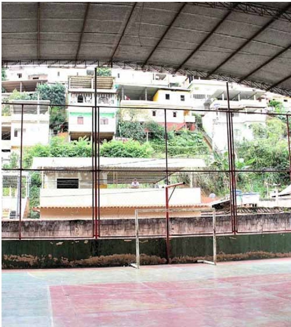
A quadra receberá reparos no piso, no teto, nova pintura, instalação de novos alambrados e melhoria da iluminação
