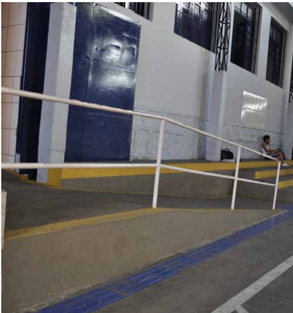
Adequações para melhorar acessibilidade nos prédios estão entre as intervenções previstas
