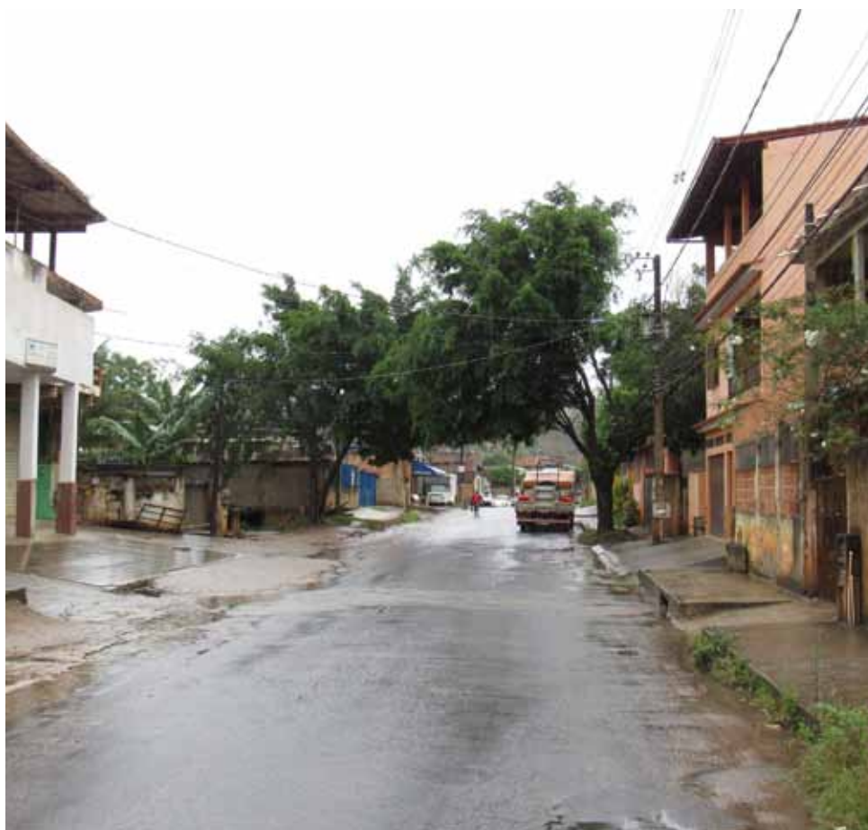
As intervenções têm por objetivo substituir 563 metros de redes antigas
