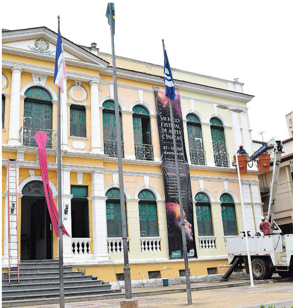
Melhorias no edifício devem ser concluídas dentro de 15 dias
