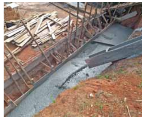
Nesta quarta-feira (10), foi finalizada a concretagem da base da edificação
