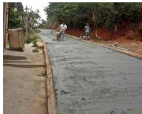
Na rua Leocádio Coelho Valdo, bairro São Geraldo, serviço foi concluído nesta semana
