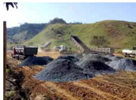
*O Revsol tem consistência semelhante ao concreto e é ideal para o asfaltamento de vias rurais*
