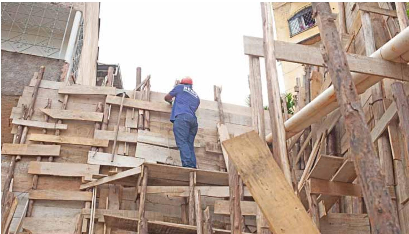
Falta apenas a sedimentação da concretagem para a retirada dos apoios de madeira
