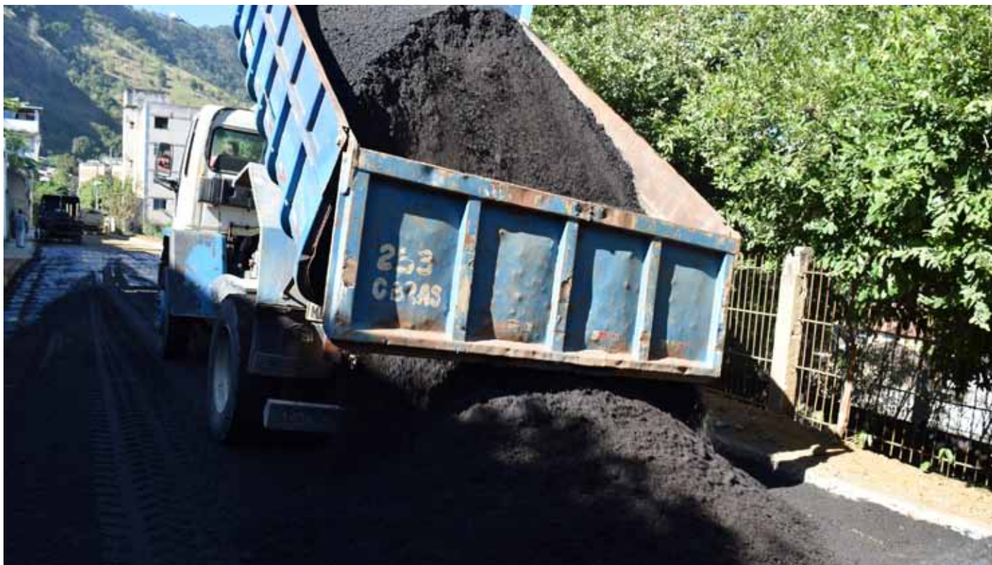
Obras incluem recomposição asfáltica e pavimentação de algumas vias
