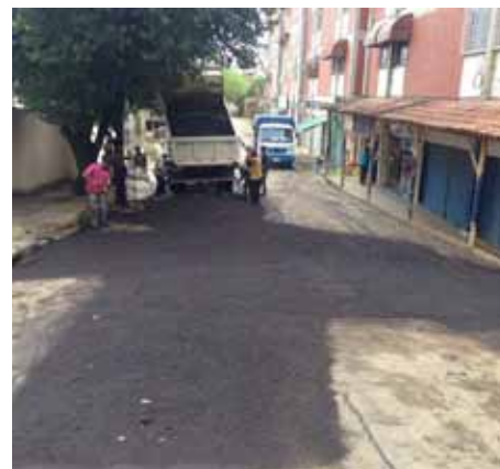
Ruas que receberam as intervenções estão tendo o asfalto repost
