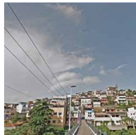
Foram pelo menos quatro ocorrências em 60 dias, a última delas na ponte de pedestres Rosalina Depolli.
