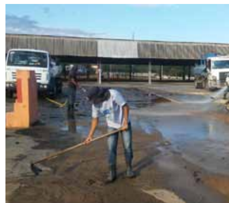
Local recebeu limpeza, pintura e melhorias estruturais
