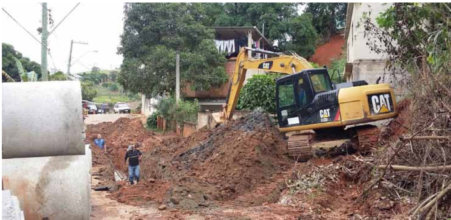
Nova rede na rua Plínio Vieira Machado, no Rubem Braga, terá cerca de 500 metros.
