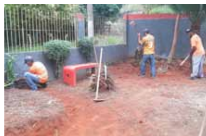
Área externa está ganhando novos jardins e calçadas com piso antiderrapante
