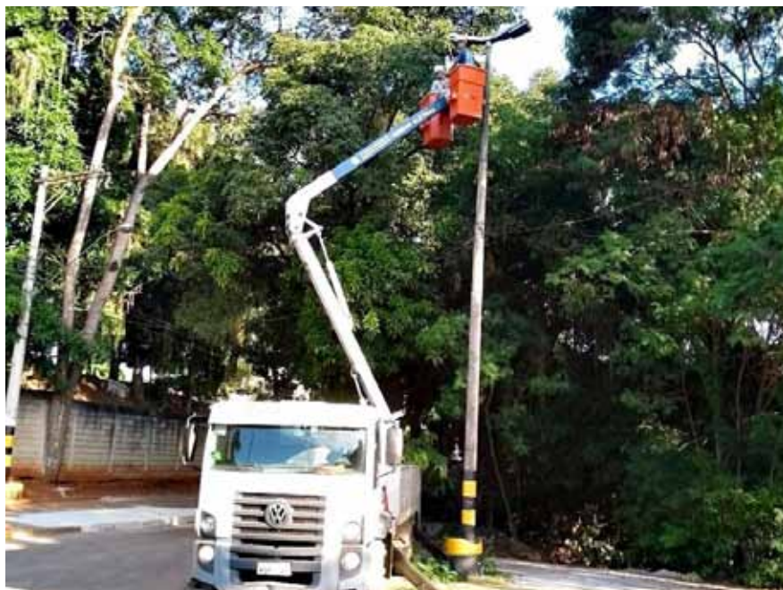
Lâmpadas dos postes foram trocadas; próximo passo é reparar iluminação da parte coberta
