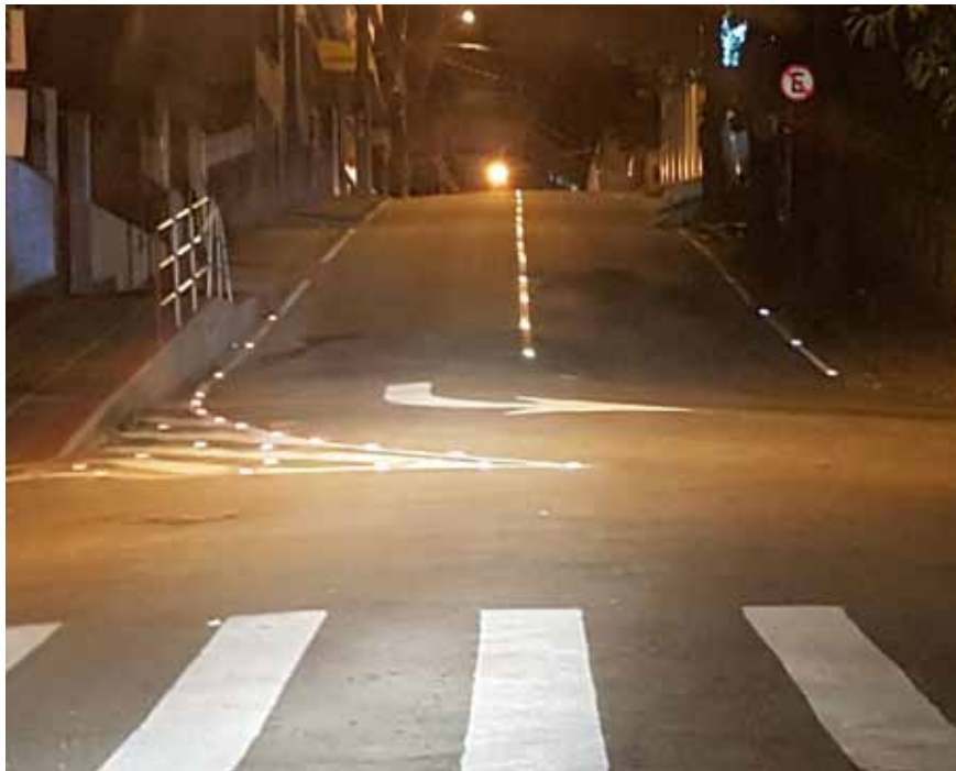
O asfalto nos trechos de maior movimento e conversões ganhou ainda tachas reflexivas
