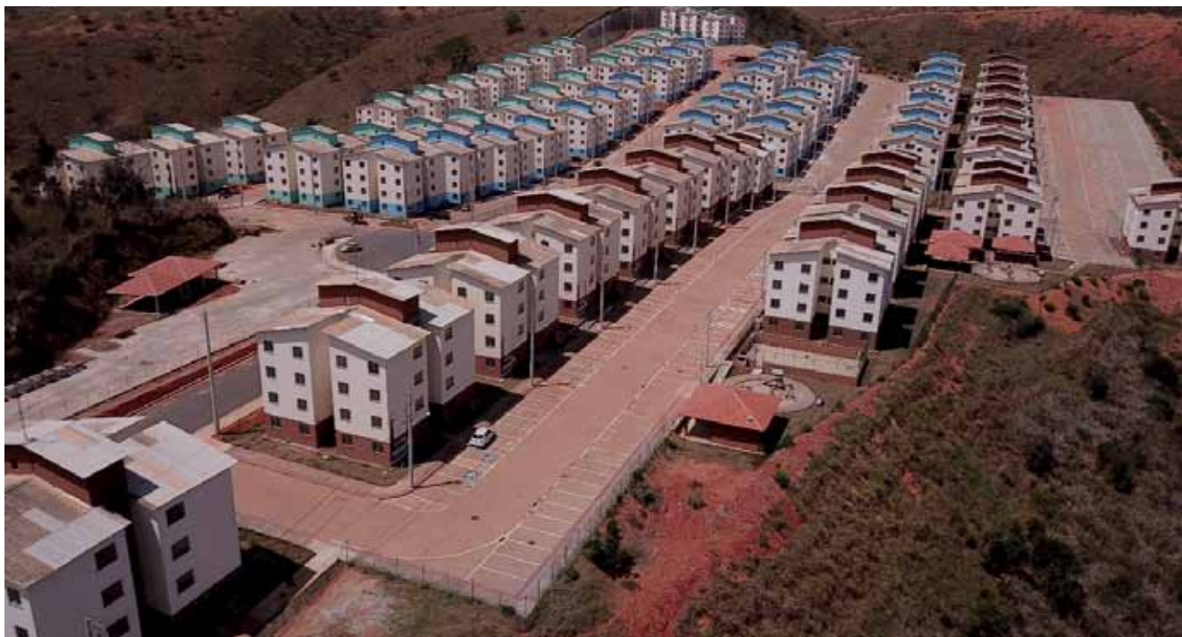
Em construção, o Otilio Roncetti tem obras acompanhadas pela Caixa Econômica Federal
