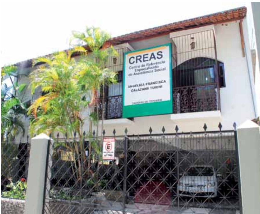
O Creas, localizado na rua 25 de Março, faz acompanhamento de quem sofreu violações
