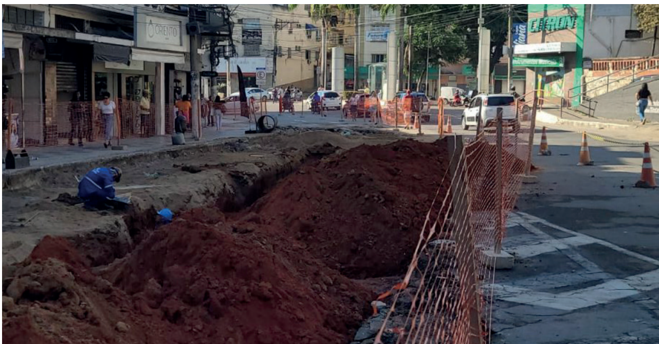
Obras avançam na rua Coronel Francisco Braga
