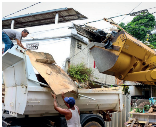
Limpeza de vias é um dos serviços executados
