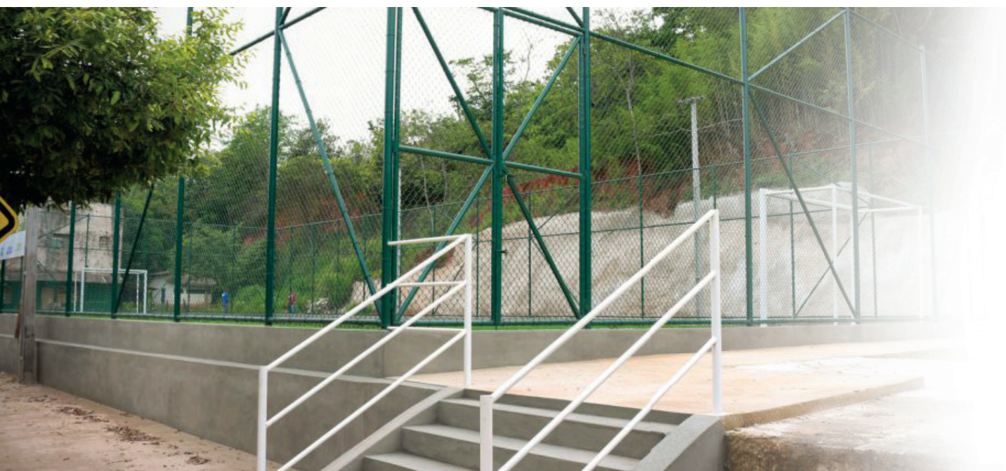
Campo de futebol do distrito de Conduru foi uma das obras entregues
